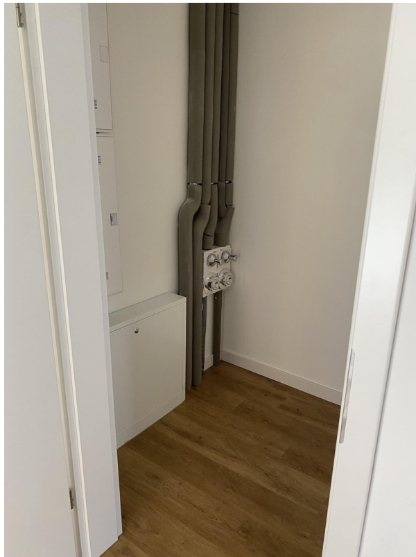
Abstellraum in der Wohnung
