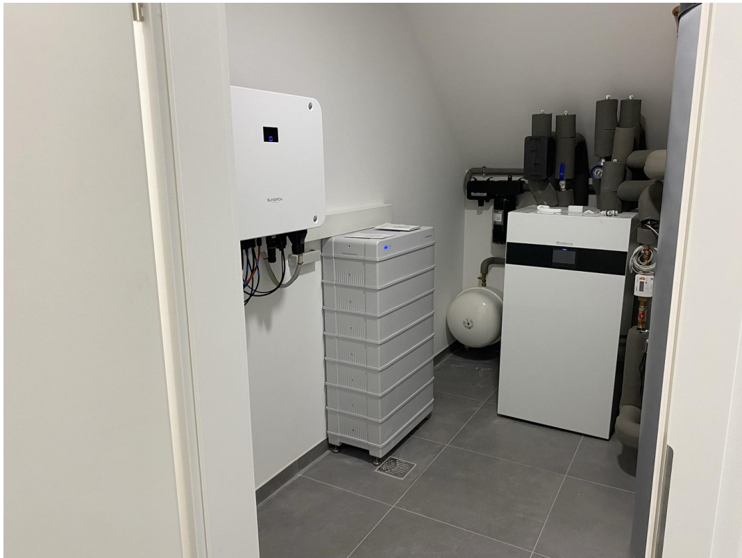
Wechselrichter + Batt-Speicher
