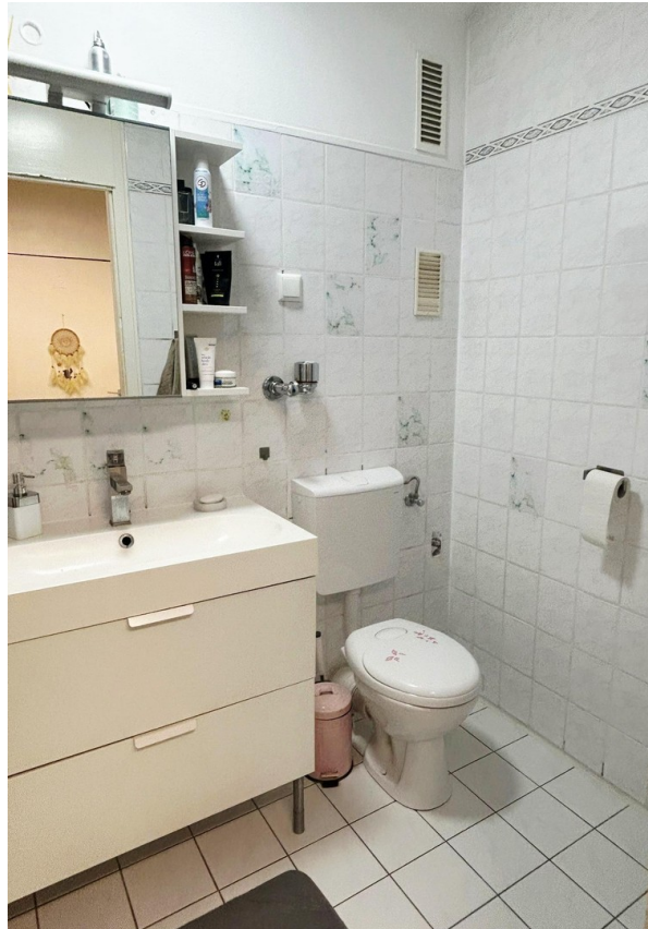
Bad mit WC (vor Renovierung)
