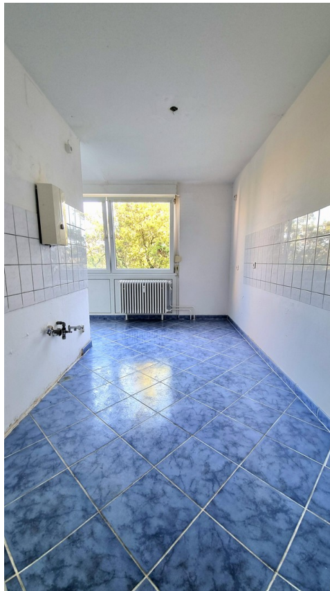
Küche (VOR RENOVIERUNG)
