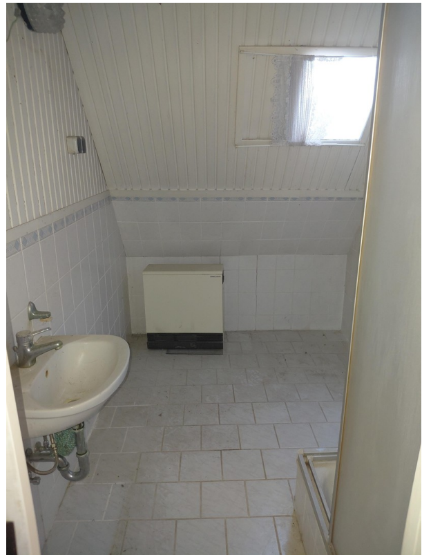
OG-Bad mit Dusche
