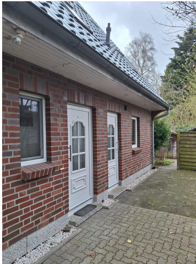
Hauseingang und Heizungsraum
