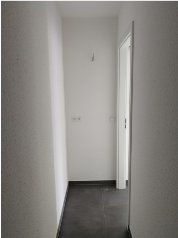
Abstellraum EG (innen)
