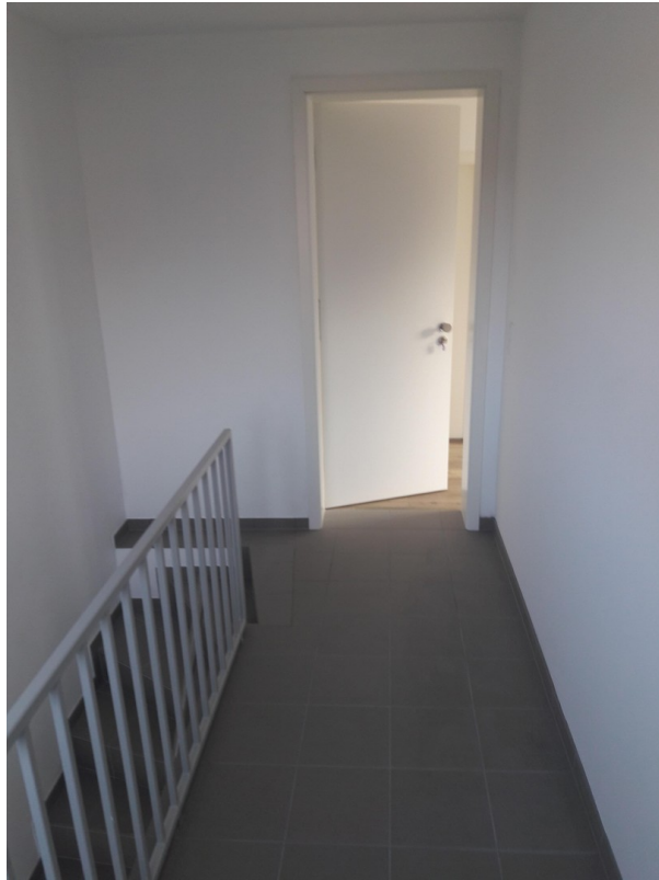
Flur vor Wohnung zur Nutzung
