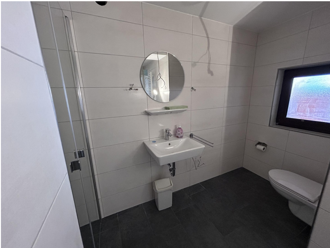
frisch renoviertes Duschbad
