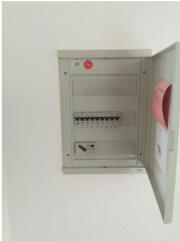
Sicherungskasten
