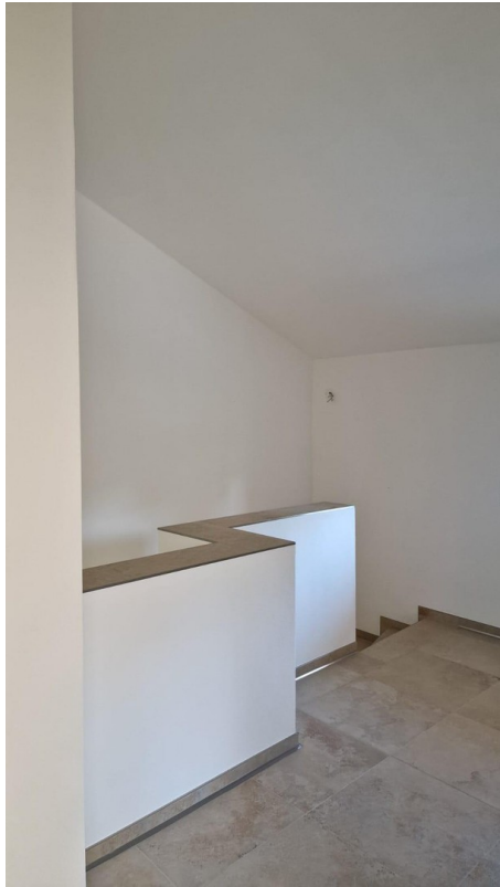
Abgang OG Treppenhaus
