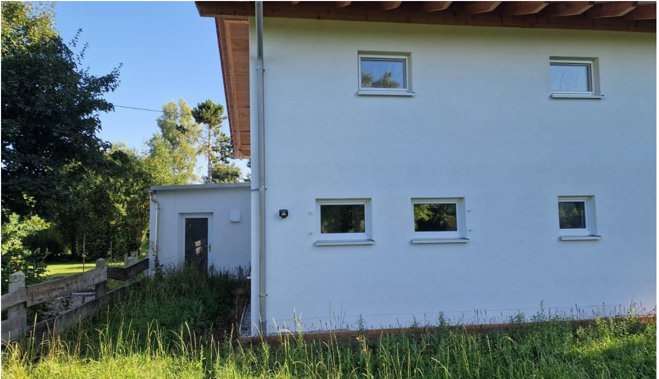
Blick von Süden auf Anbau
