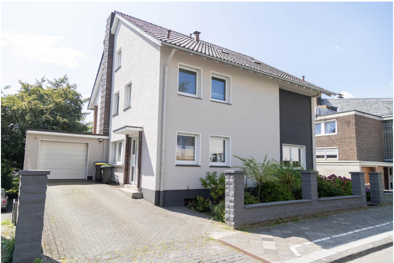
Strassenansicht mit Garage
