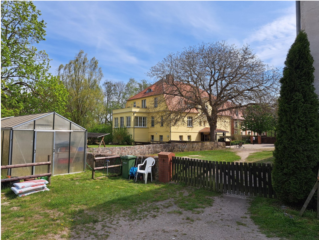
Blick auf Innenhof
