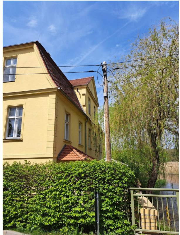
Blick von der Straße
