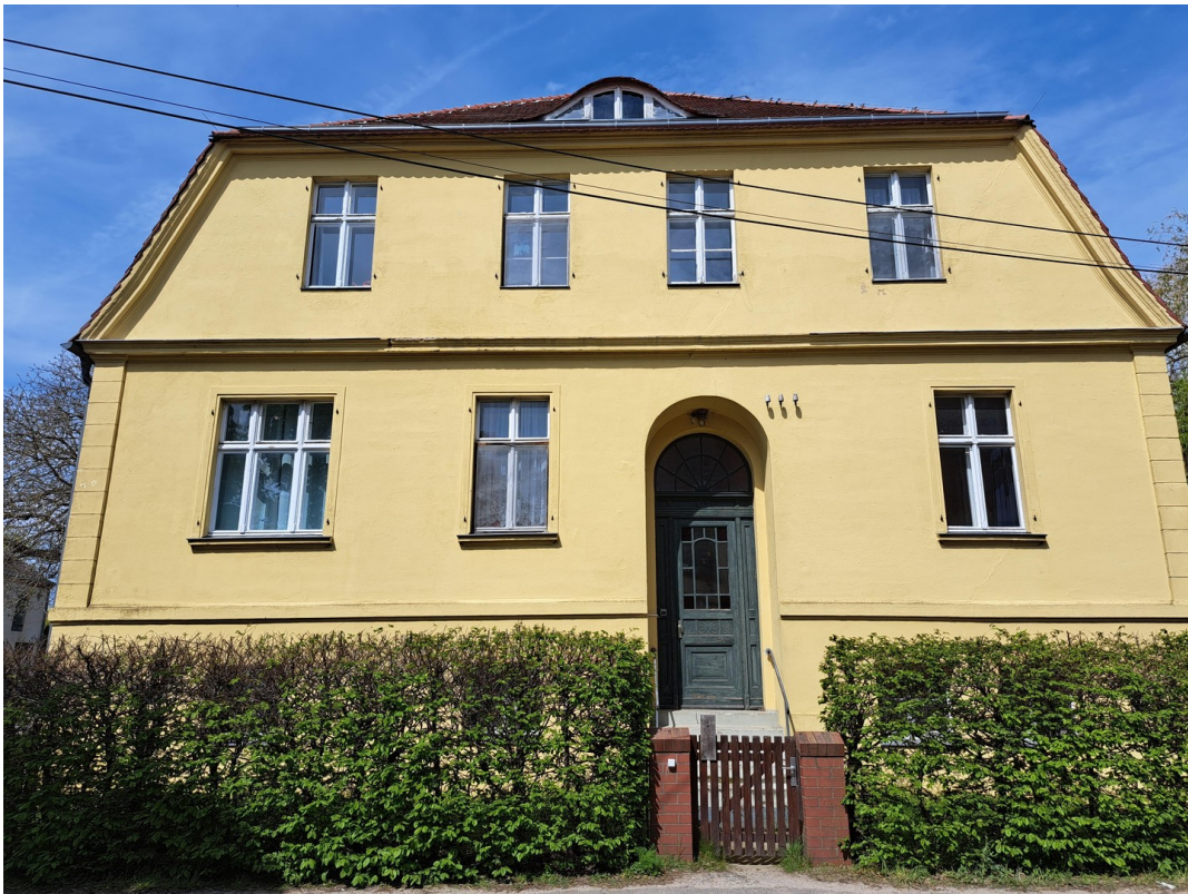
Blick auf Straßeneingang
