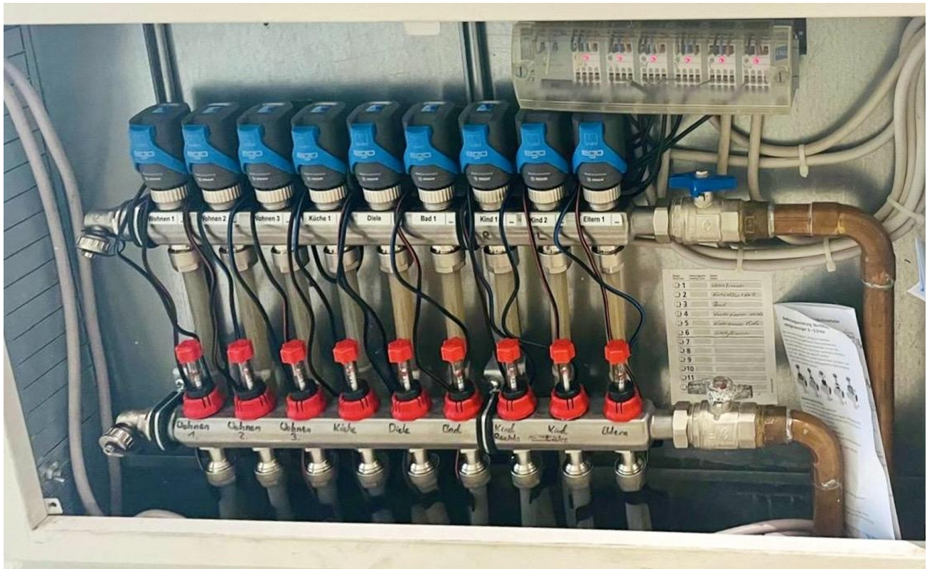
Heizungsverteiler
