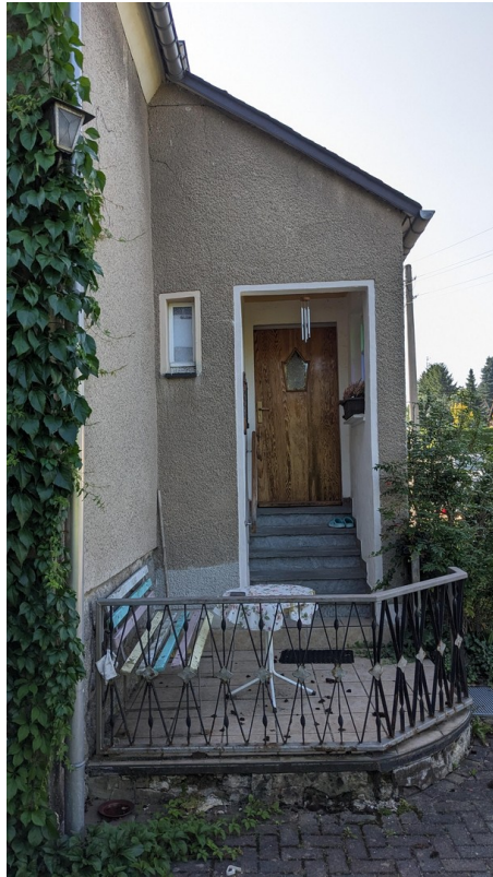
Eingangsbereich mit Windschutz
