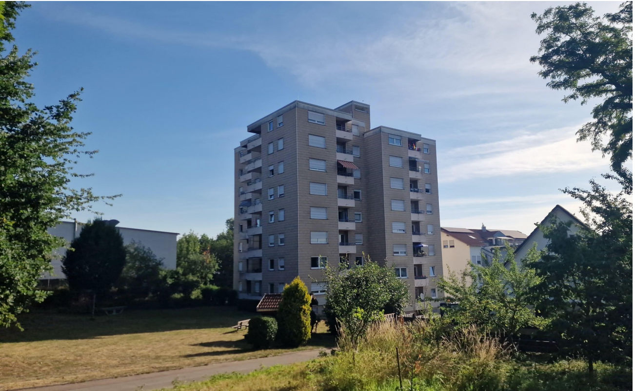
Außen gesamtes Haus
