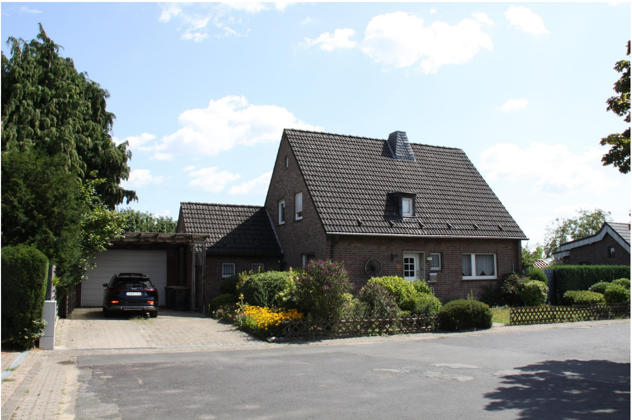
Frontansicht mit Garage
