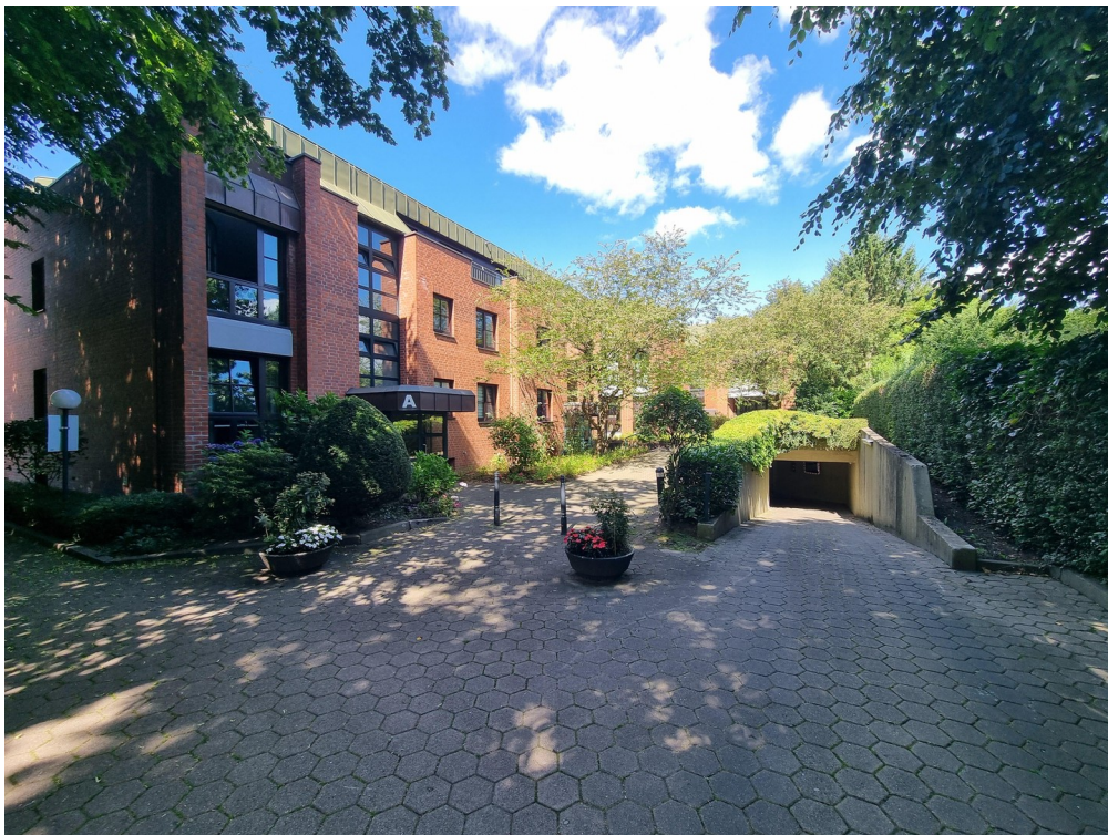
Einfahrt zur Tiefgarage
