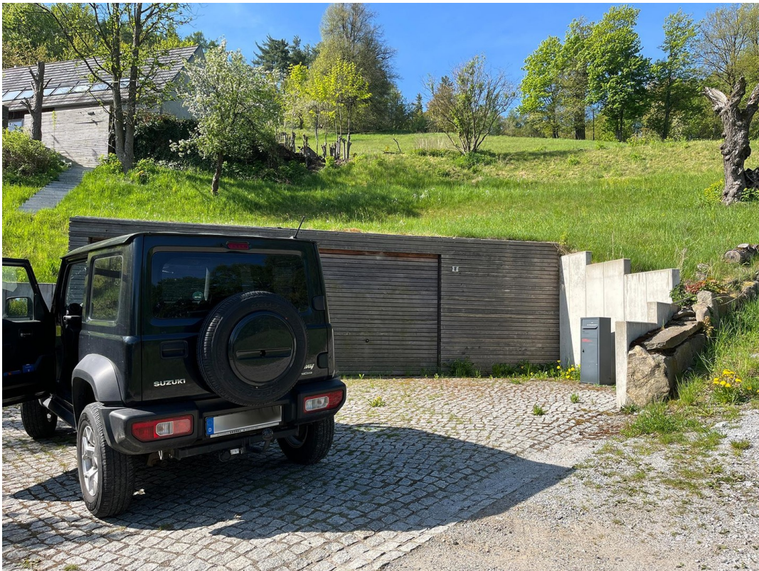
Doppelgarage mit Stellplatz
