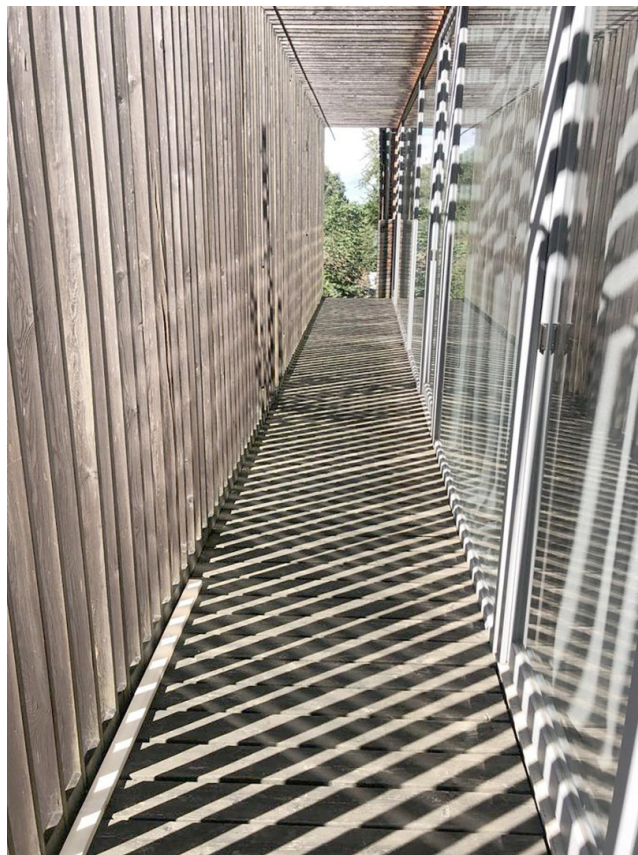
südwestlicher Laubengang OG
