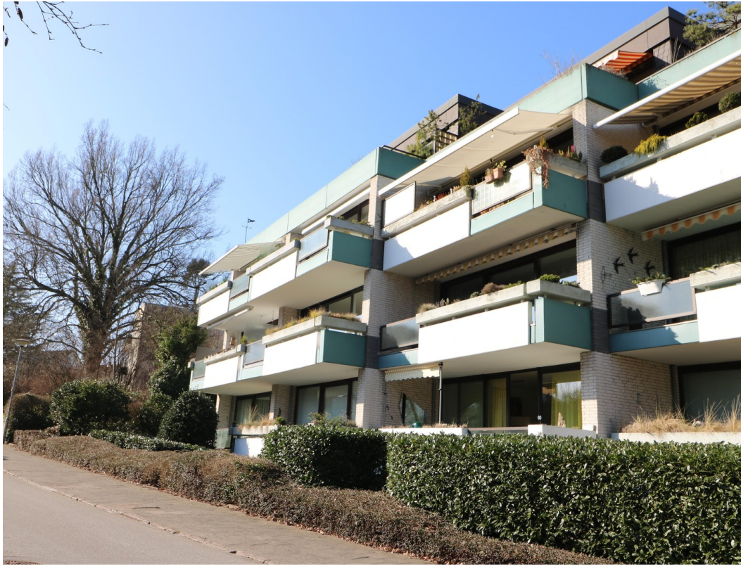
Ecklage im Gebäude
