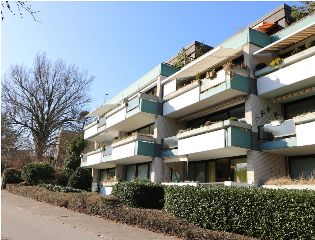
Ecklage im Gebäude
