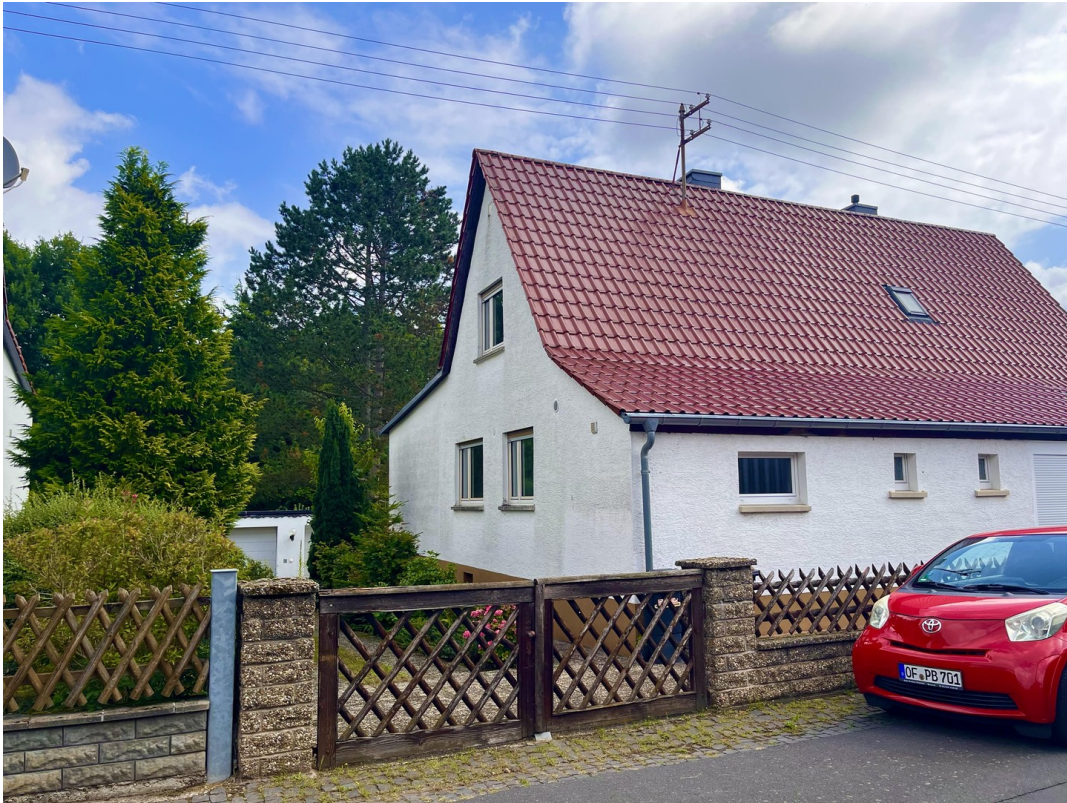
Haus von der Straße
