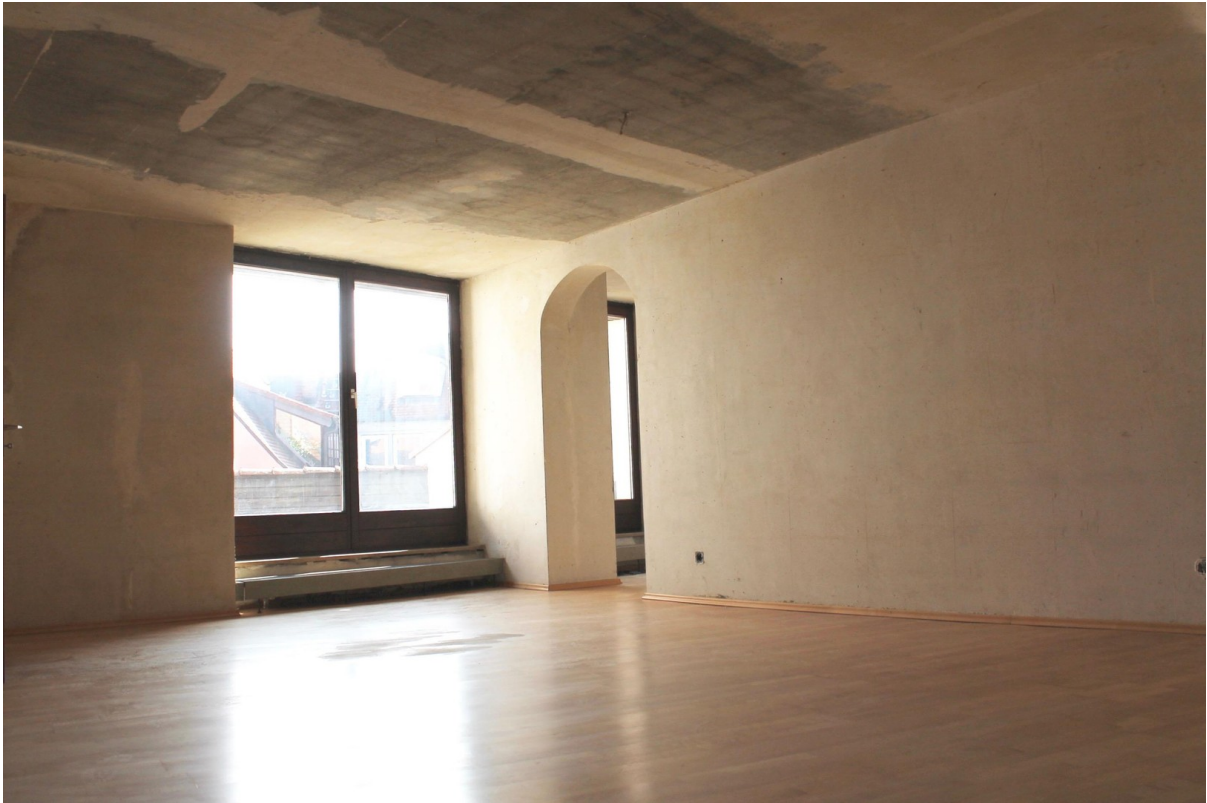
Raum 3 Blickrichtung Süden
