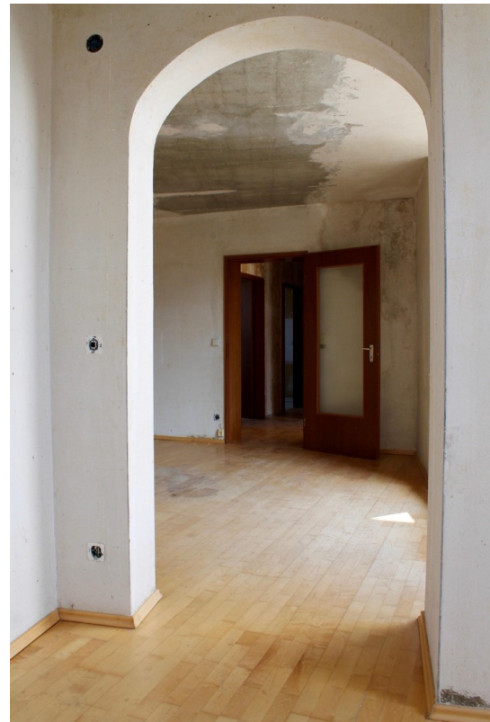
Blick aus R4 in R3 und Flur
