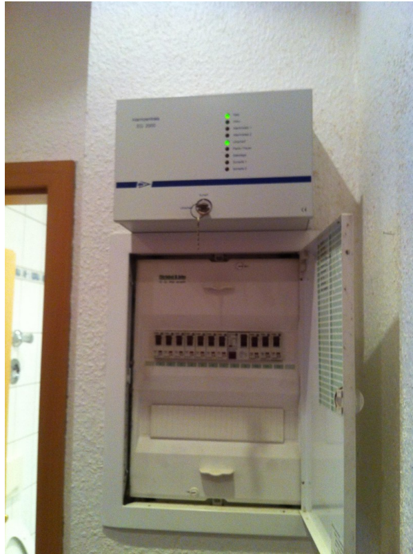
Sicherungskasten / Alarmanlage
