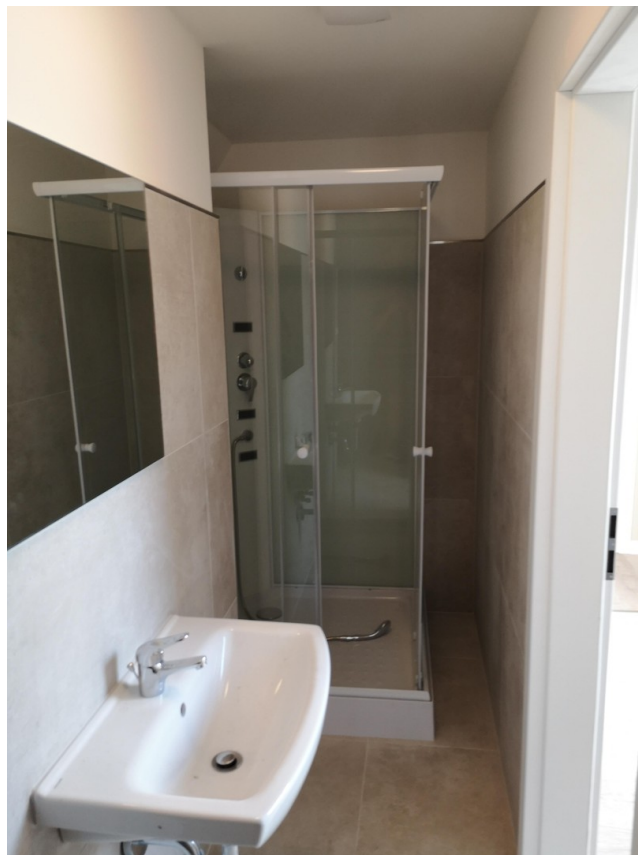
Duschbad mit Toilette im DG
