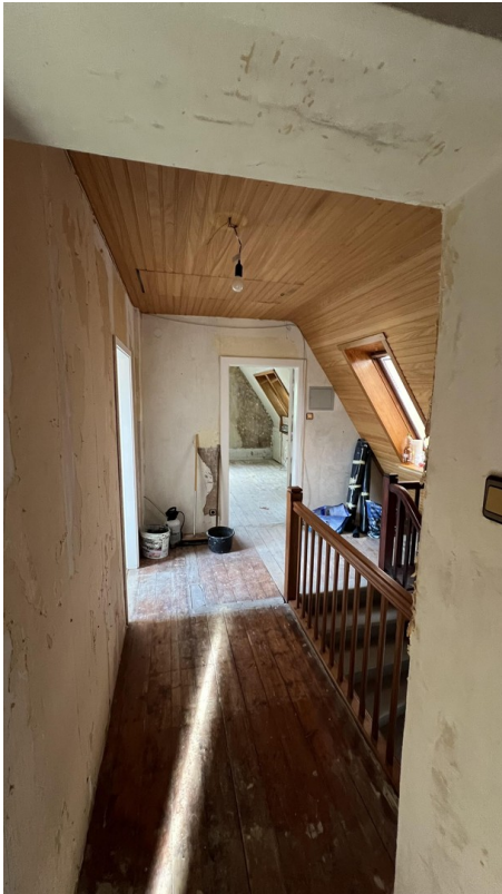
Flur im 1. OG
