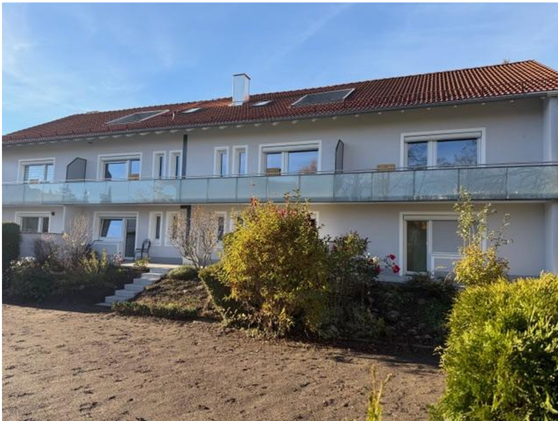
Wohnanlage von hinten
