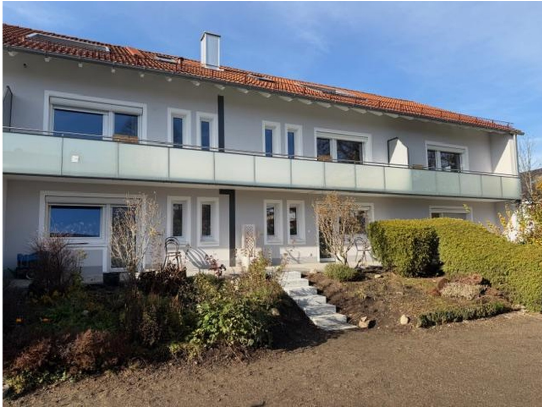
Wohnanlage von hinten
