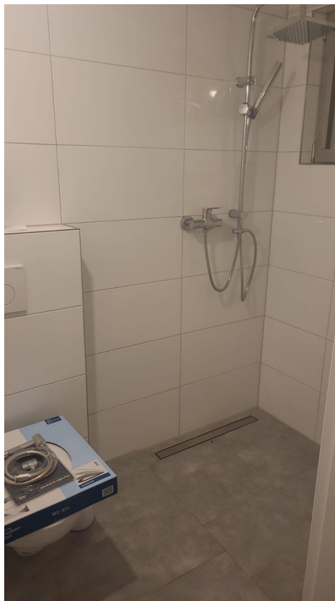
Barrierefrei Du/WC im Anbau
