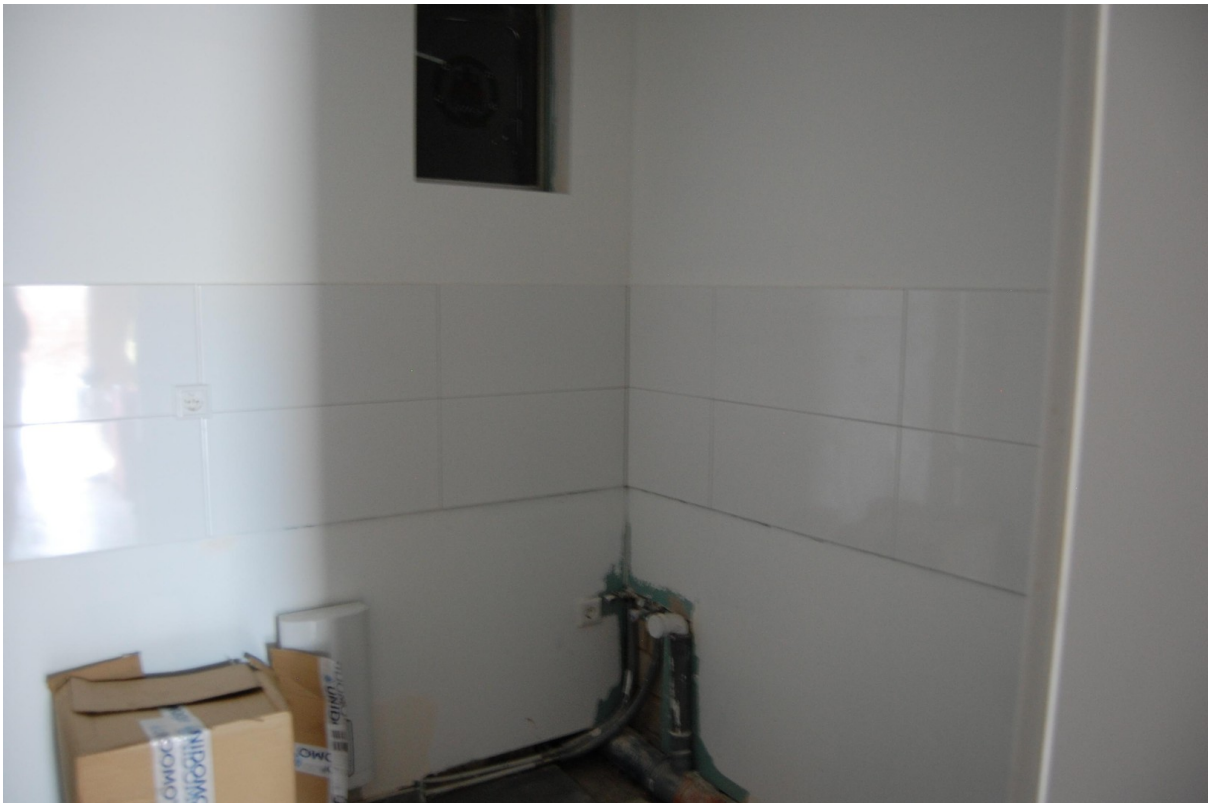
Neue Küche im Anbau
