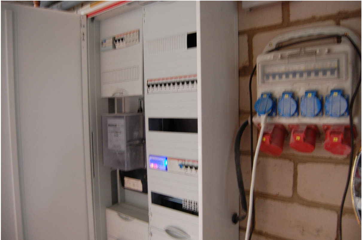
Neuer Stromverteiler
