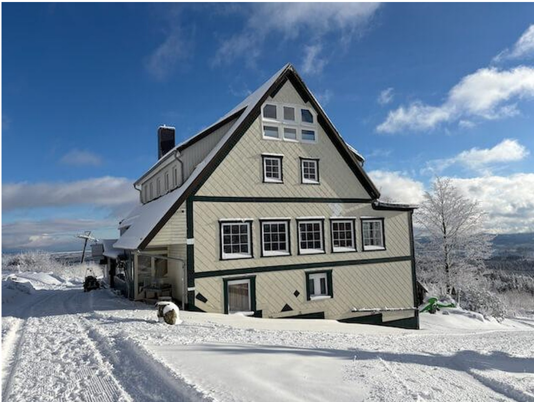
Blick von West
