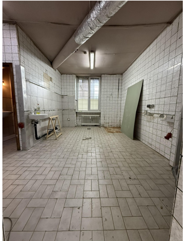
Ehemalige Küche - Fenster
