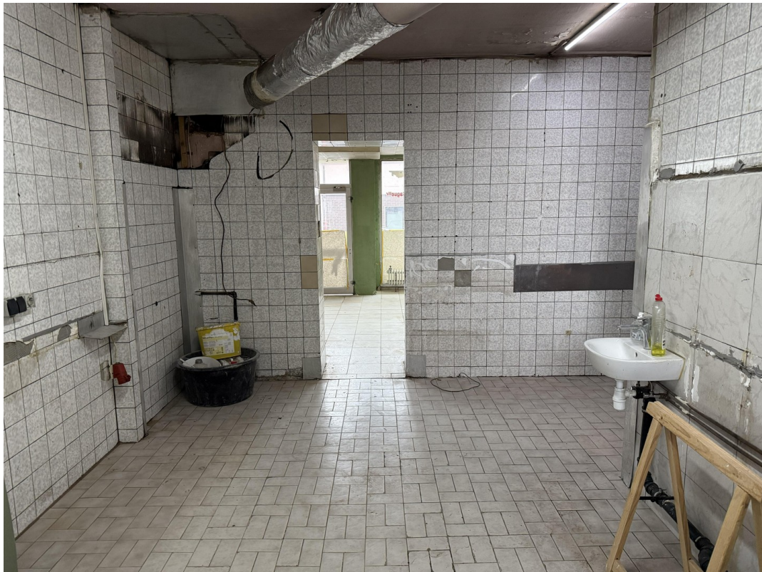
Ehemalige Küche - Tür
