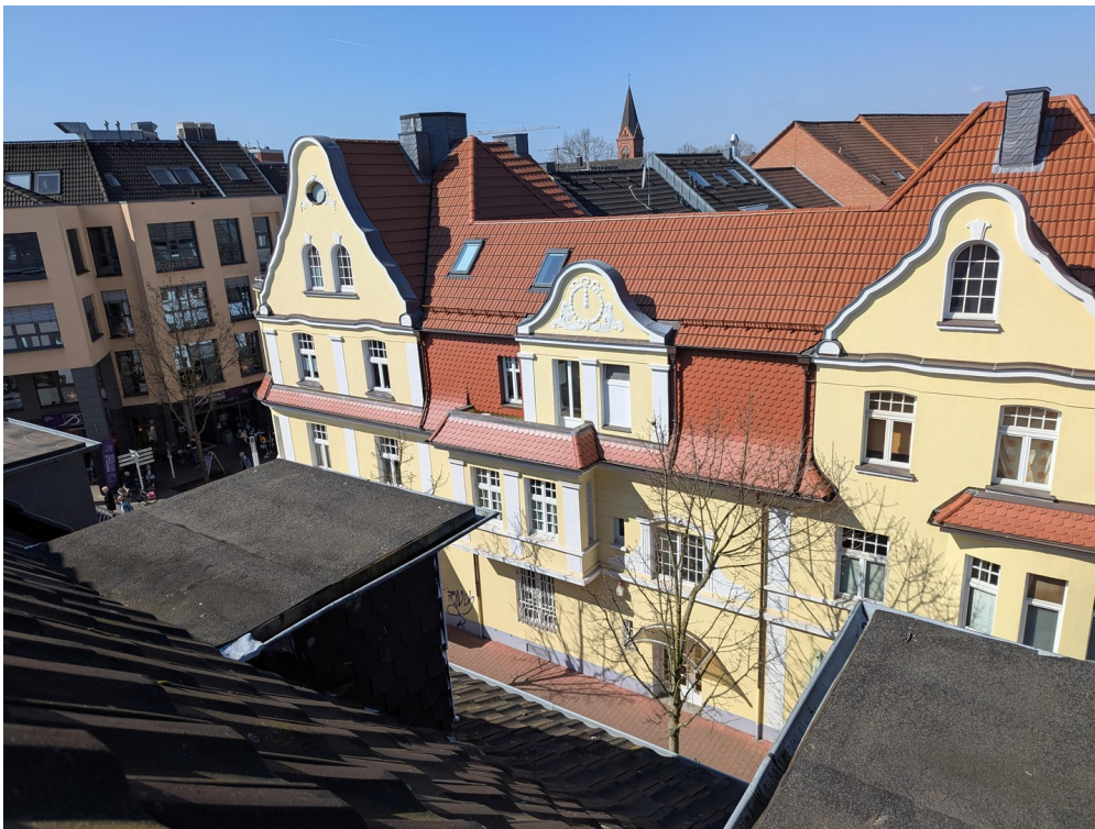
Blick Richtung Norden
