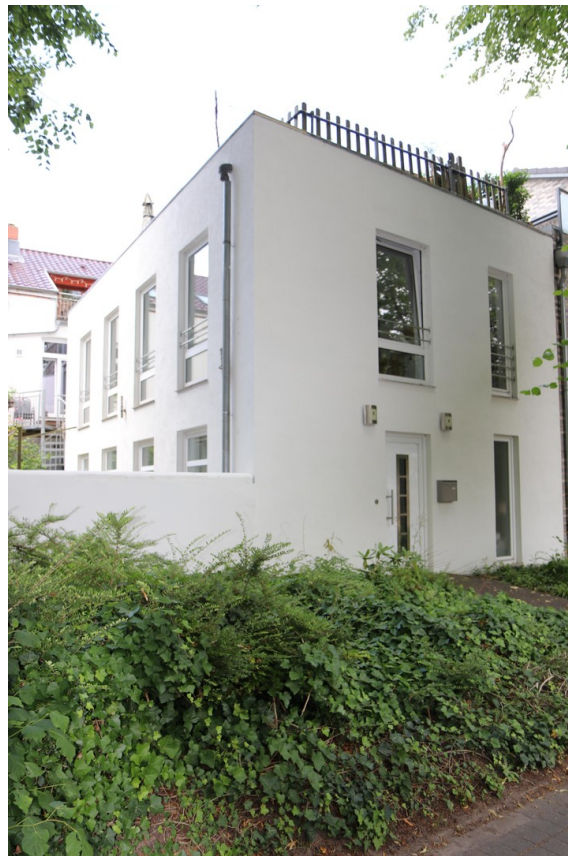
Neubau Am Exer
