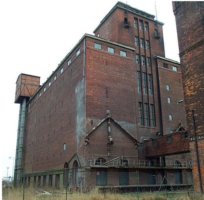
Abbildung: Löwespeicher in den 2000er, DSK GmbH
