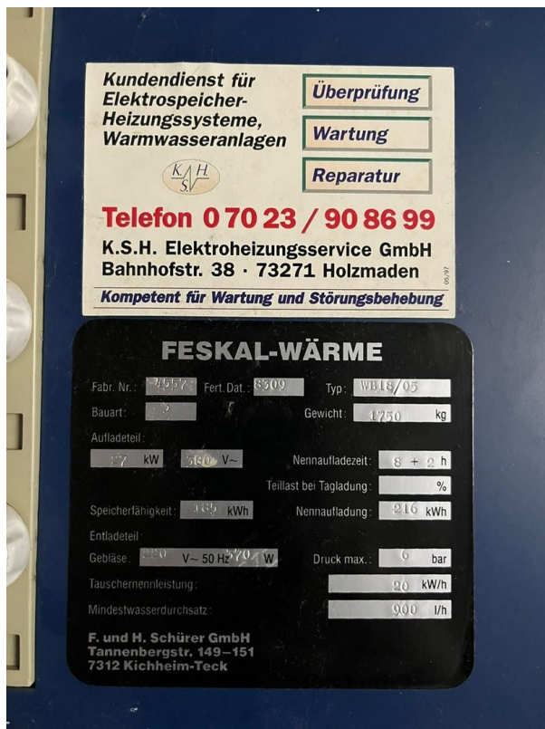
Typenschild Heizungsanlage
