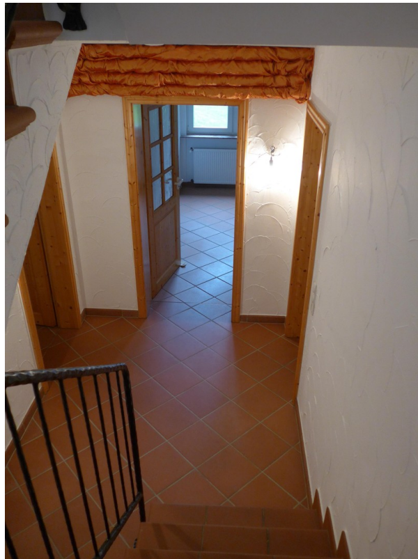
Blick Treppe EG ins Souterrain
