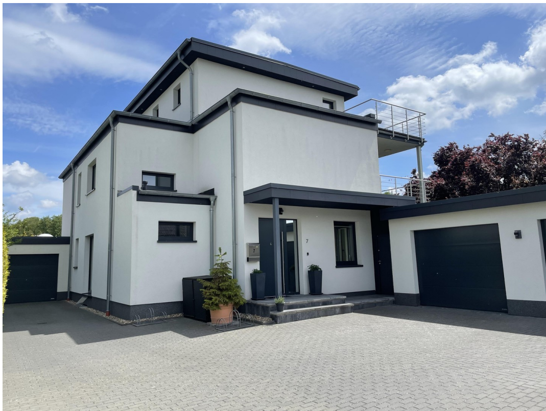
Hauseingang und 3 Garagen
