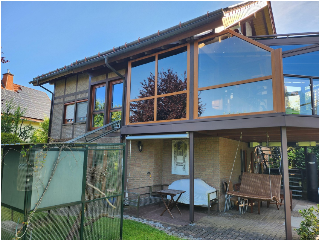
Südwest, unten Schiebetüren
