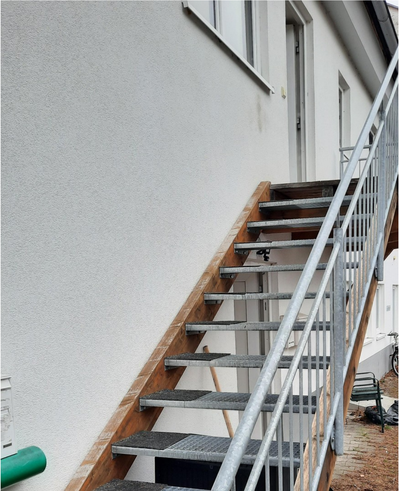
Zugang 1 OG mitte
