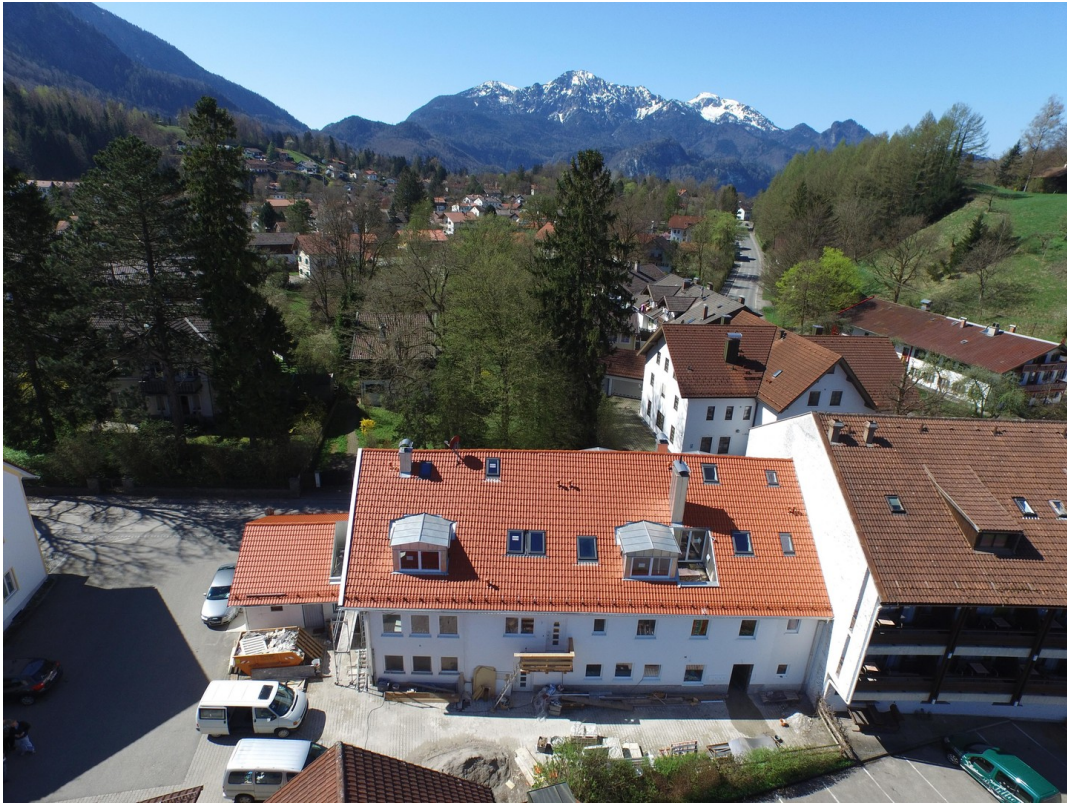
2015 während der Sanierung
