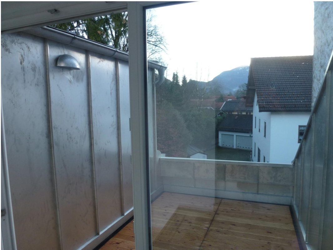
Dachterrasse DG rechts
