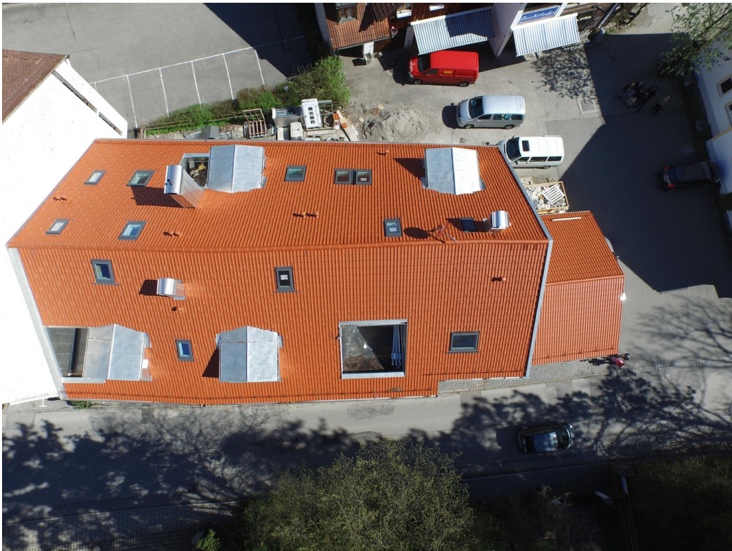
2015 Dach von oben
