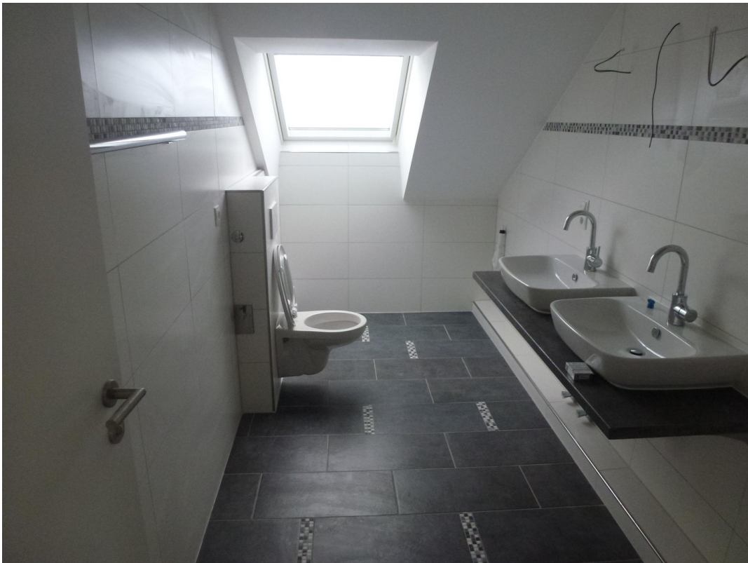
DG Mitte Bad / Dusche
