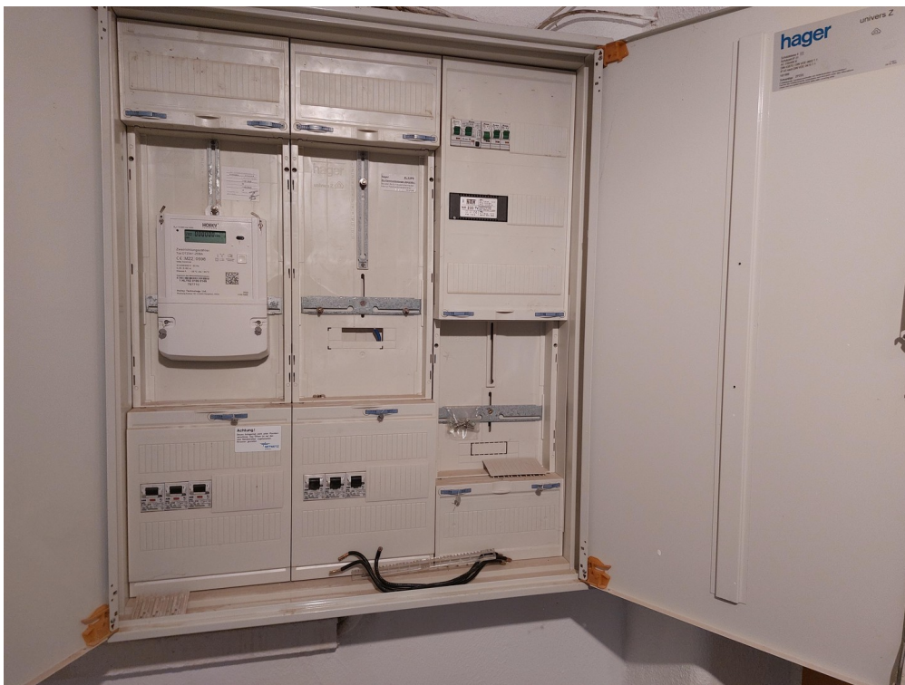
Elektrik Zählerschrank
