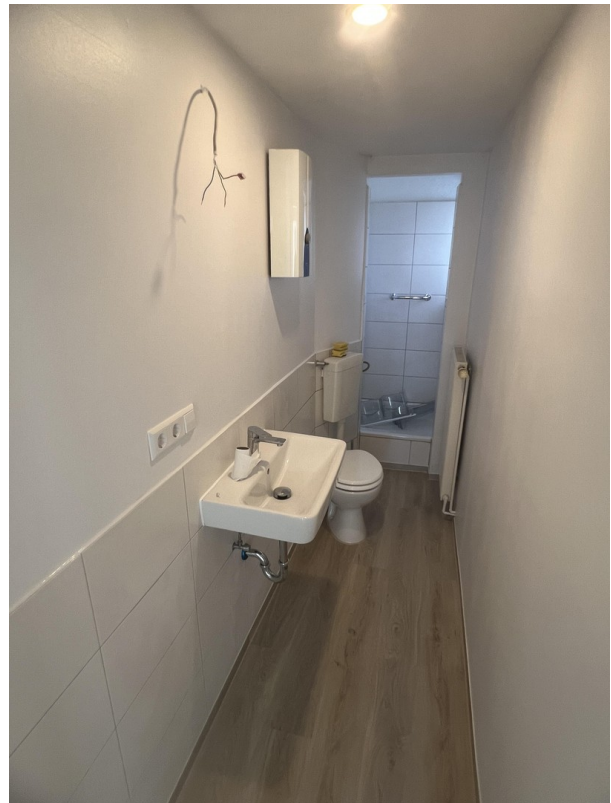
Haus 85 I. OG Bad
