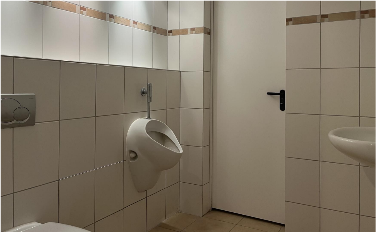
WC im Keller
