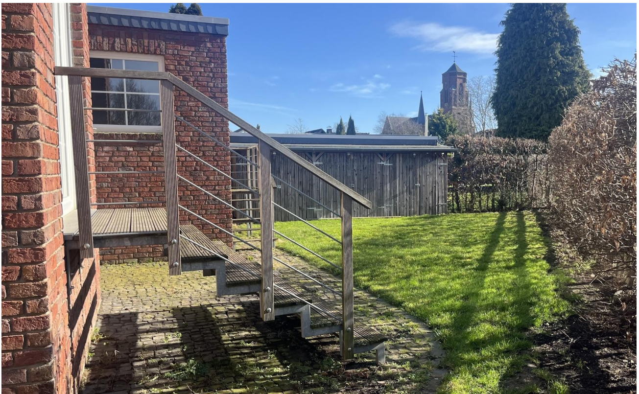
Blick auf den Schuppen
