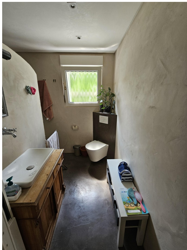
EG Bad mit Bodenheizung
