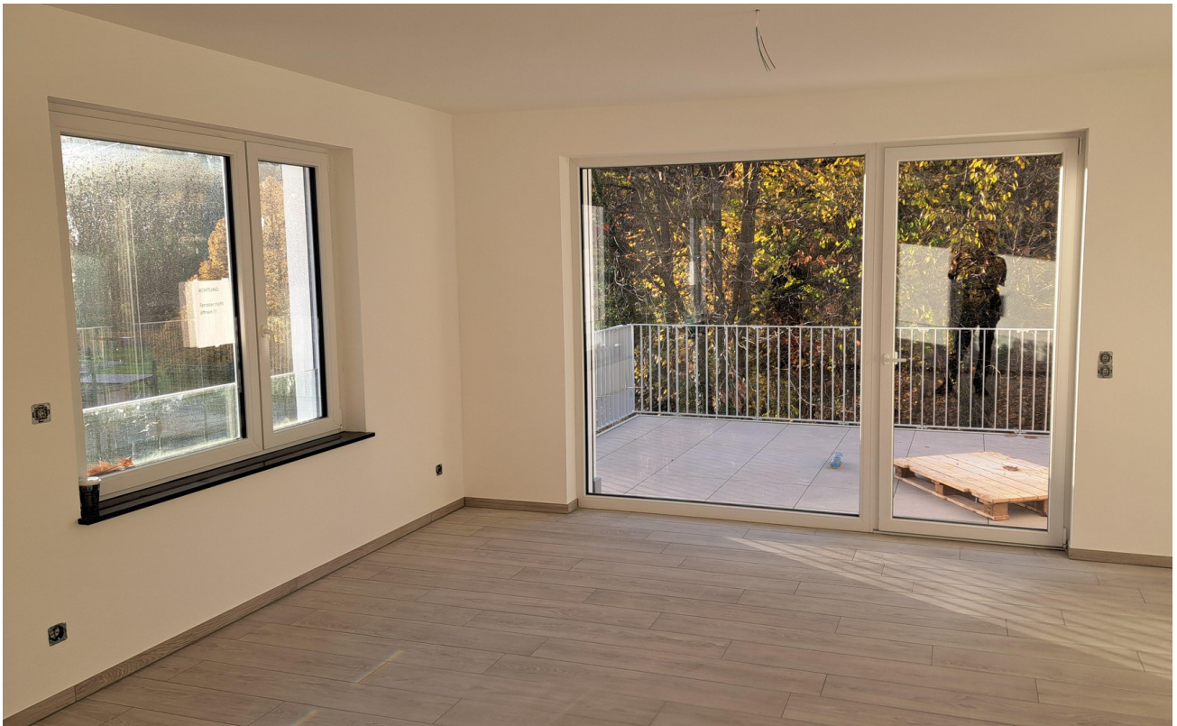
Wohnbereich OG Südwesten
