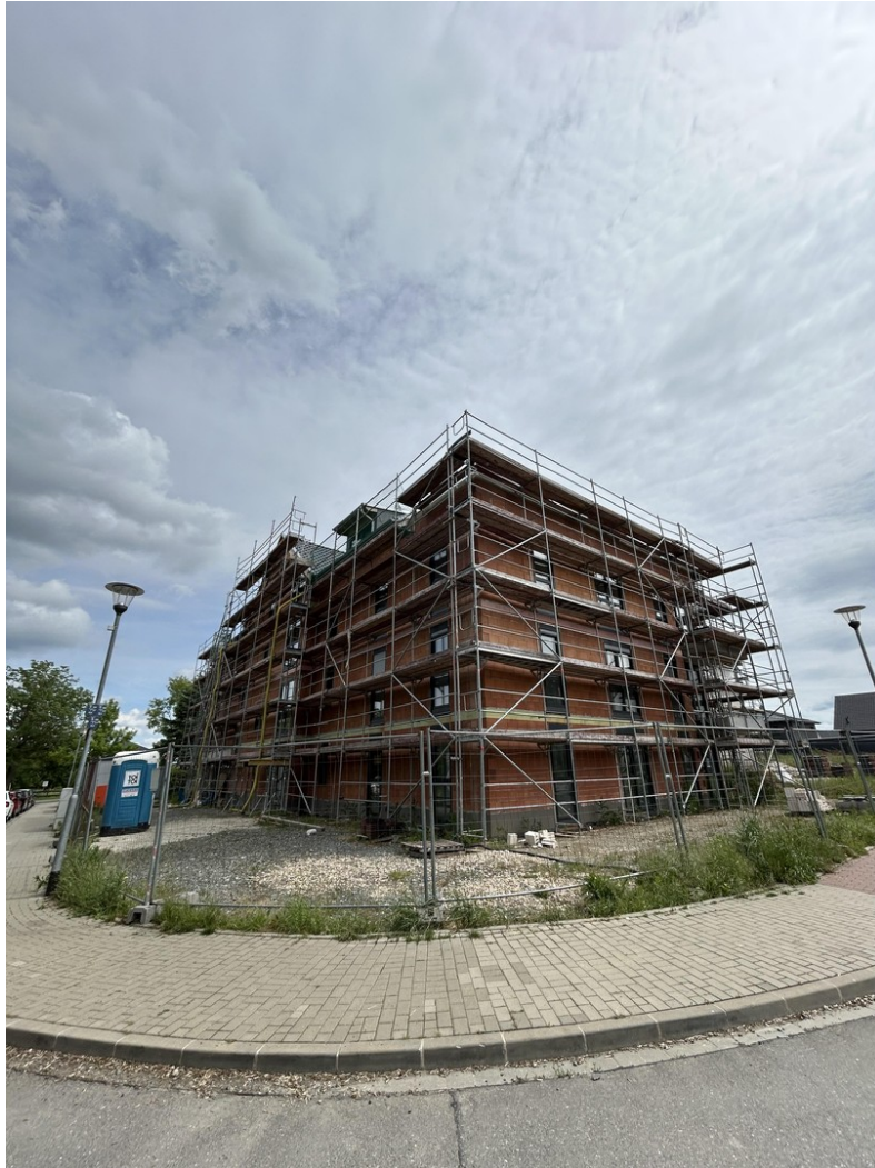
aktueller Zustand seitlich
