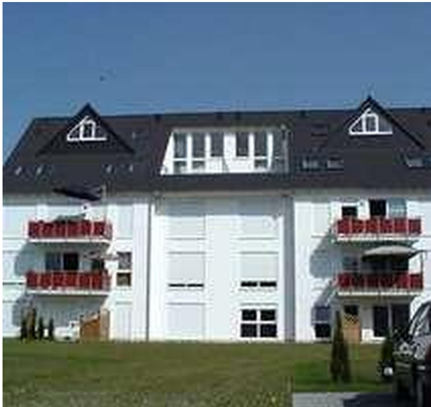
Ansicht Haus hinten
