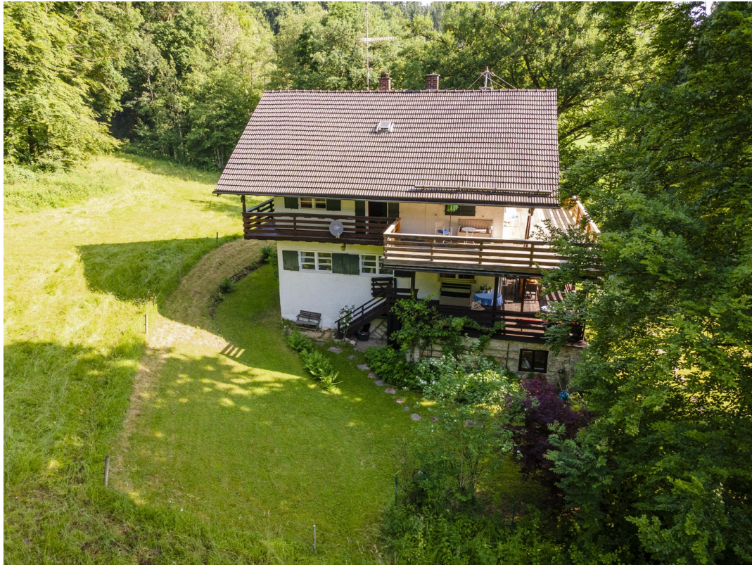
Ansicht der Südseite von oben
