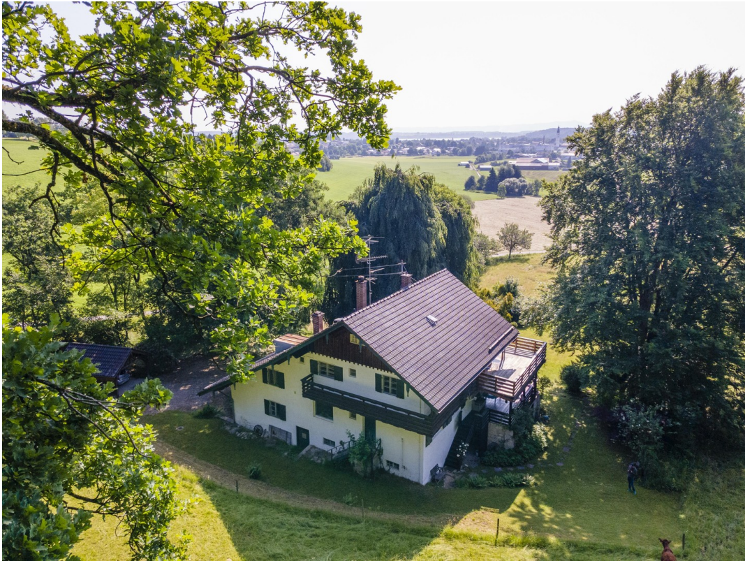
Ansicht der Westseite von oben
