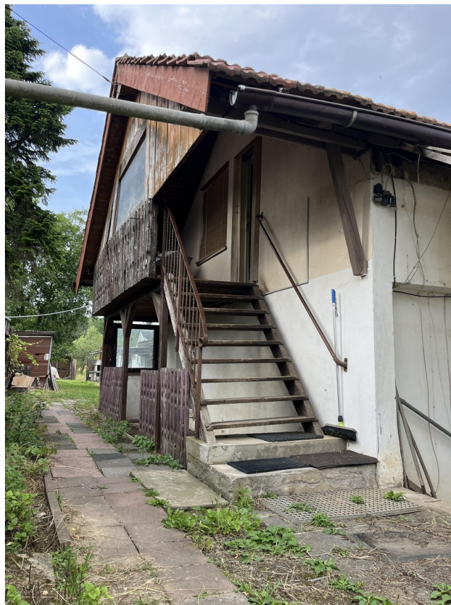
Haus - Seitlicher Eingang
