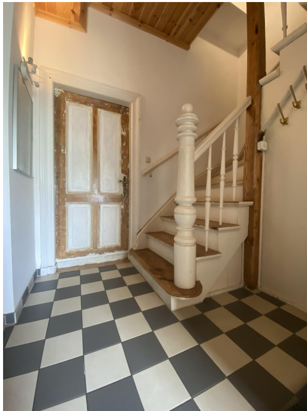
Treppe zum OG, Tür zur Whg 1
