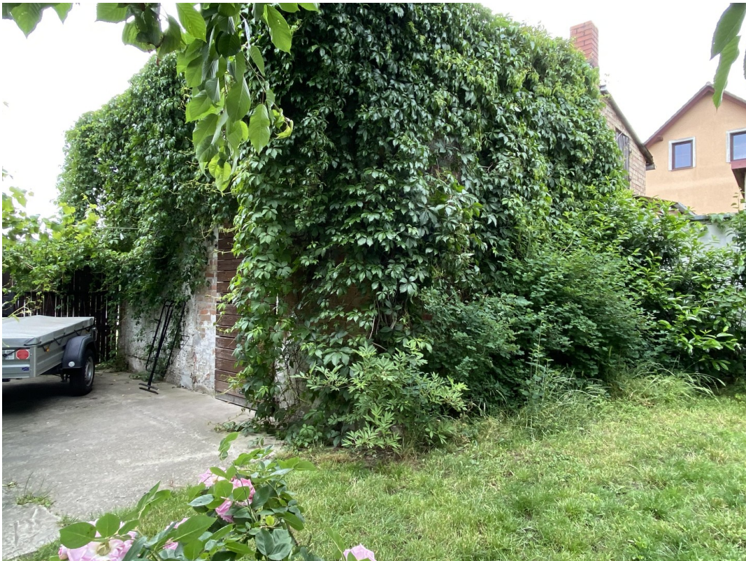
Carport, ehemaliges Backhaus
