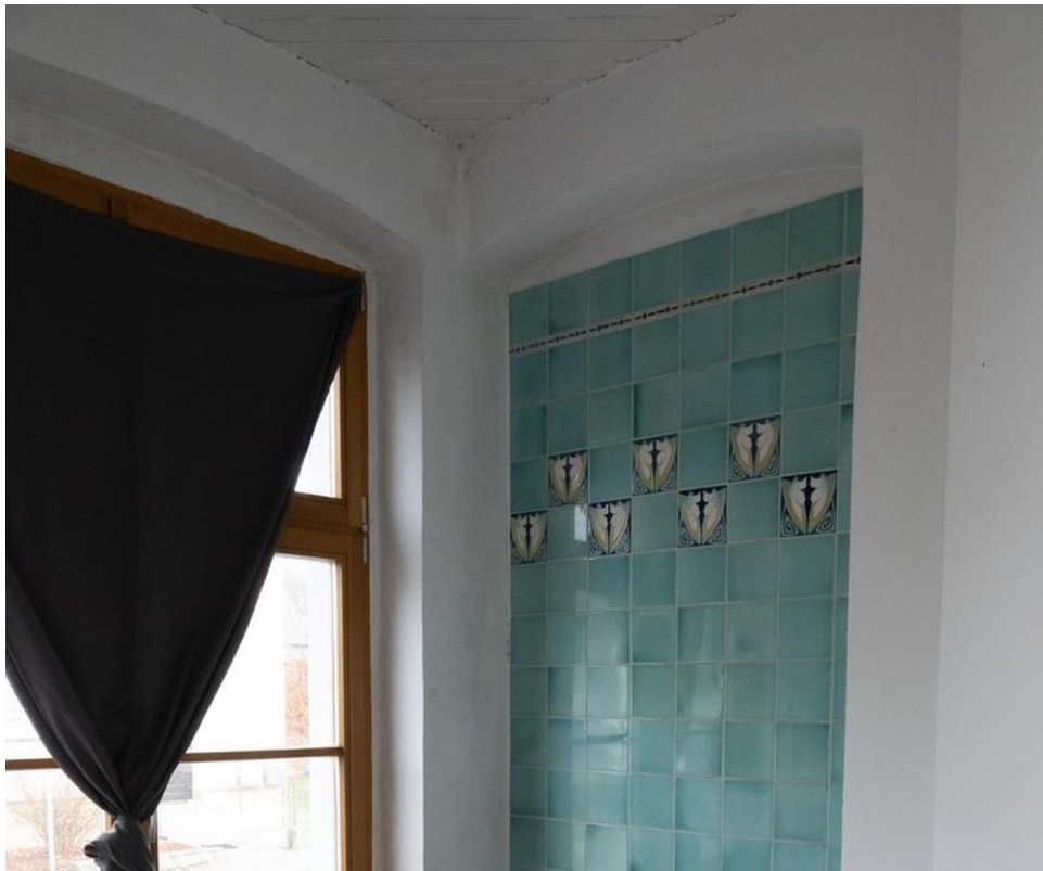
Erkerzimmer, EG, Whg 1
