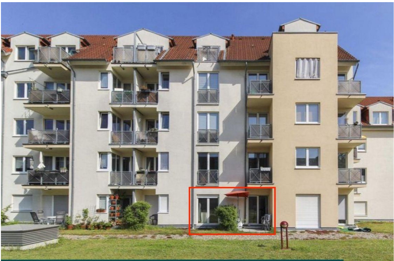
Hausansicht Blick auf Terrasse
