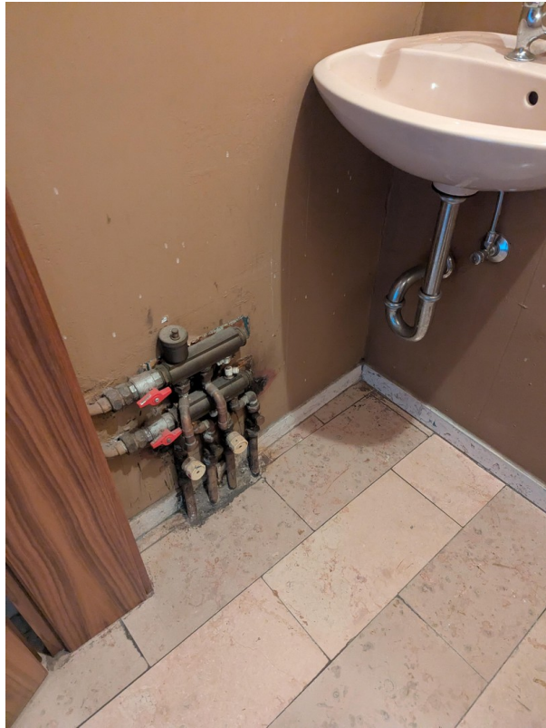
Fussbodenheizung OG
