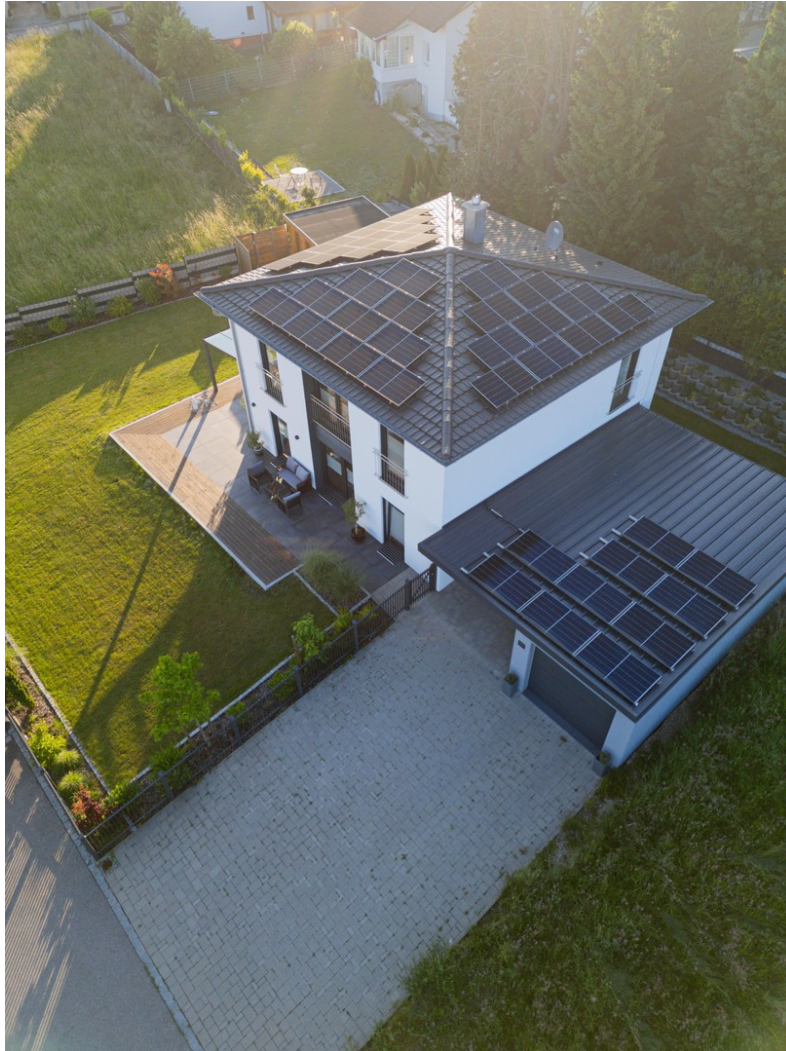
Anwesen, Auffahrt, PV-Anlage
