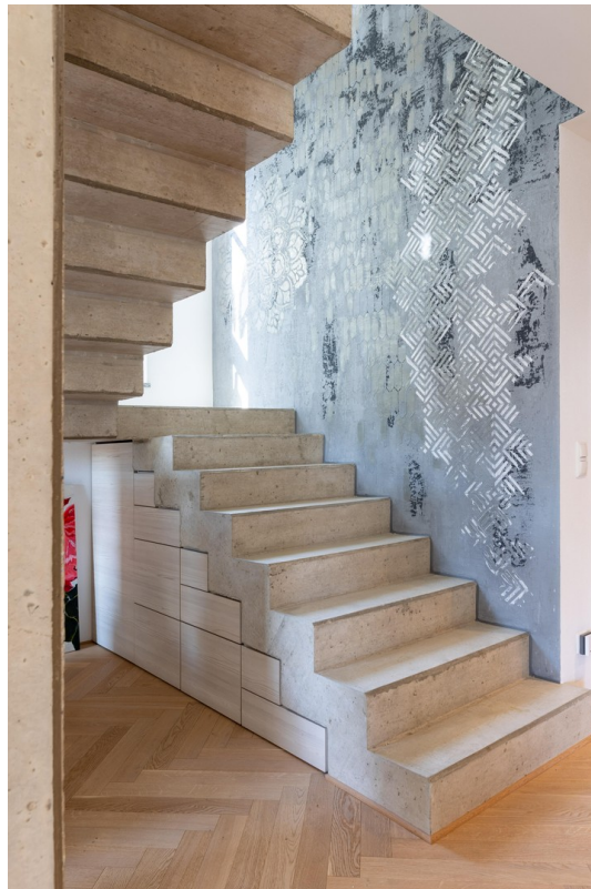
Designtreppe ins OG
