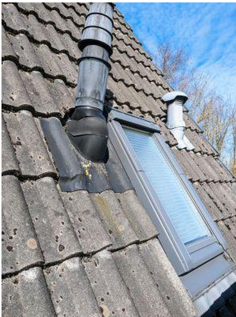
Neues Dachfenster im Bad
