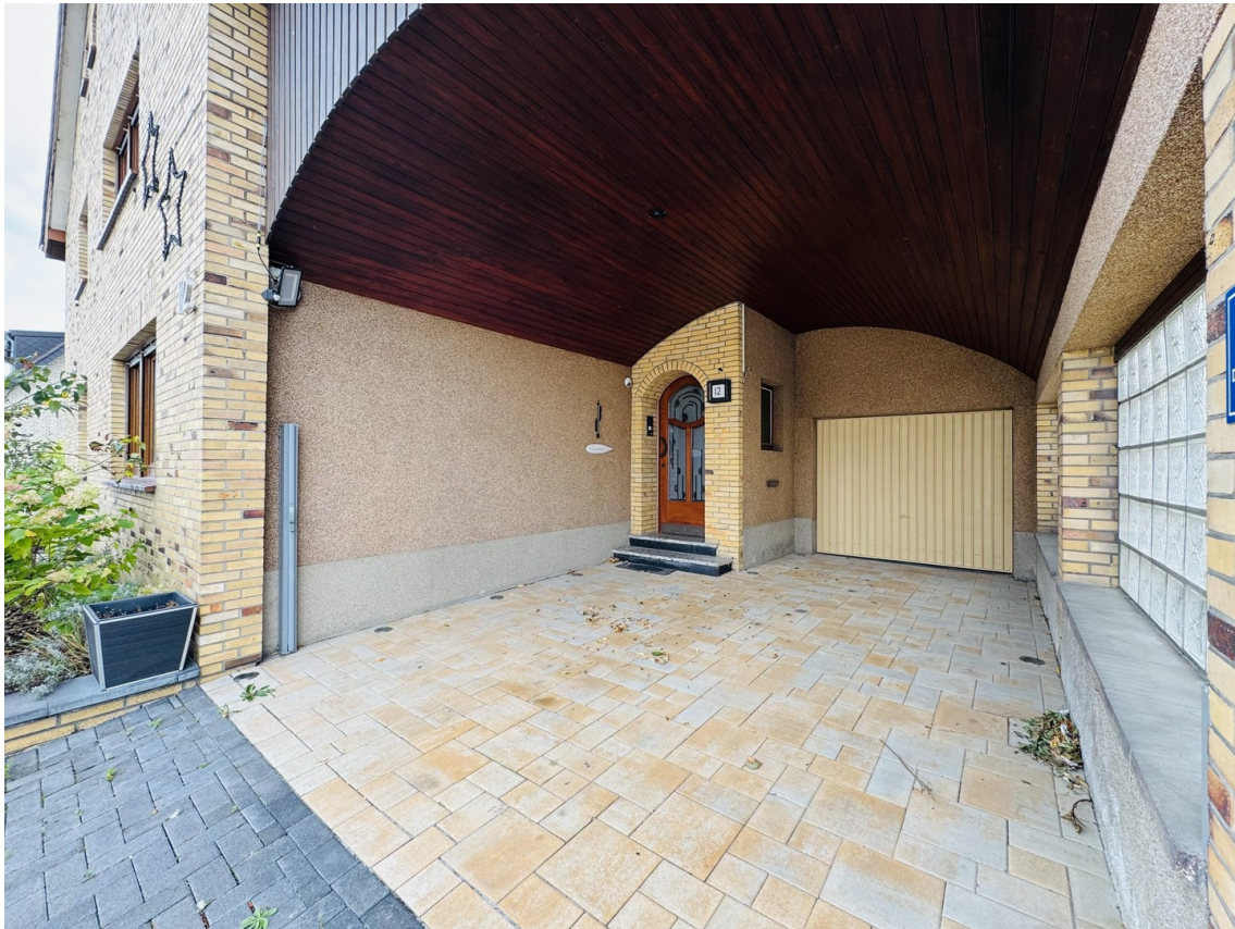
Großes Vordach mit Garage
